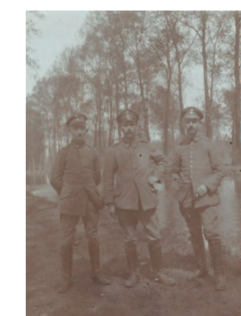
Einsatz am Kanalabschnitt
